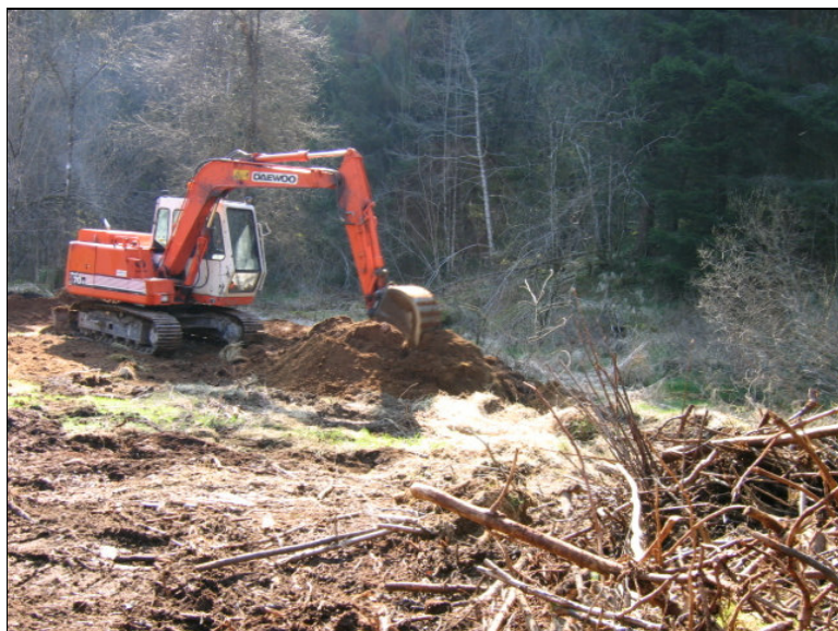
Figur 8. Toppdekket vart fjerna med gravemaskin.
